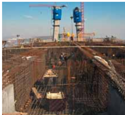
Рис. 1. Железобетонные конструкции, возведенные по технологии пред- и постнапряжения арматуры
