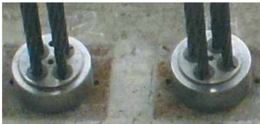
>>> >>> Рис. 7. Установка стационарного анкера
