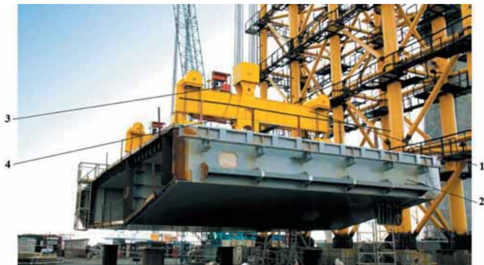
Рис. 7. Установка гидропривода на траверсе подъема блока пролетного строения:
