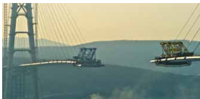
Рис. 3. Агрегат монтажа руслового пролетного строения
