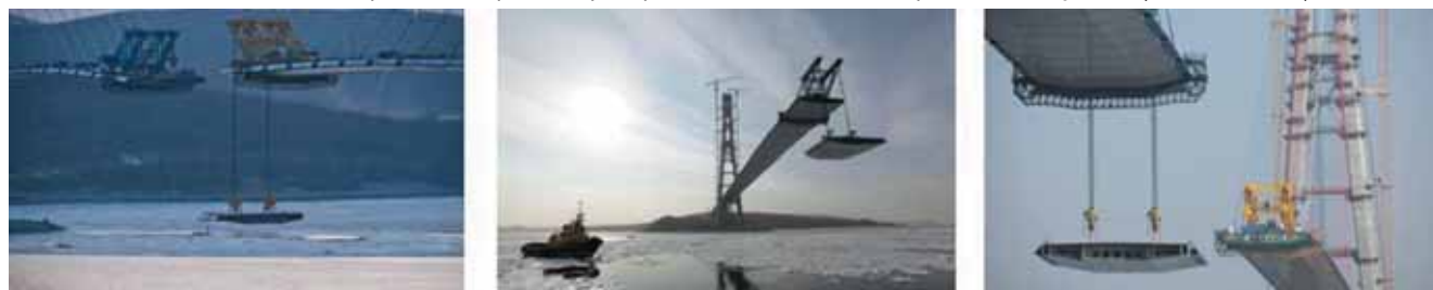
Рис. 1. Системы подъема блоков пролетных строений при строительстве мостового перехода на о. Русский (г. Владивосток)
